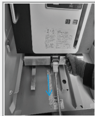
그림 3. E/F Type VCB 인출 방법 Fig.3 Withdrawing the E/F Type
